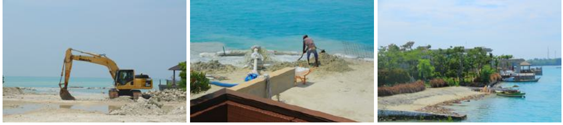
Foto xx : Kegiatan Reklamasi Pulau Tengah (Pulau H) Sumber : Dokumentasi Sudin CKTRP Kep. Seribu 2019
